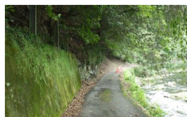
治山対策：笠城地区（宮若市）
