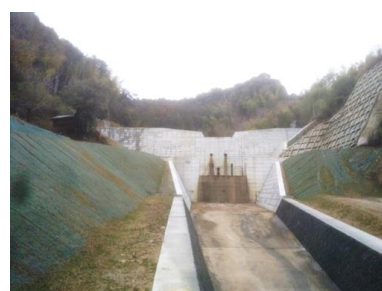
砂防施設の整備：白木谷川（朝倉市）
