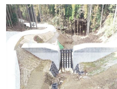
砂防施設の整備：延田谷川（東峰村）
